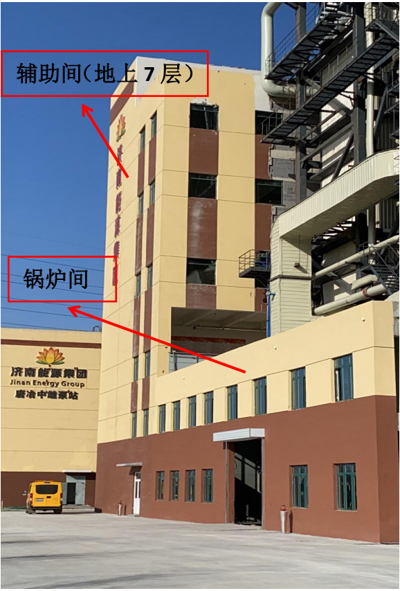
项目辅助间、锅炉间
